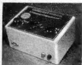
„SPION“ ein ganz neuartiger Fehlersucher in kombinierter Form. Schnellfehlersuche durch Multivibrator mit folgender Fehlerfeststellung durch Amplitudenröhre ARG 200. Mit Hilfe des „SPION“ macht die Fehlerareinkreisung wirklich Freude.
